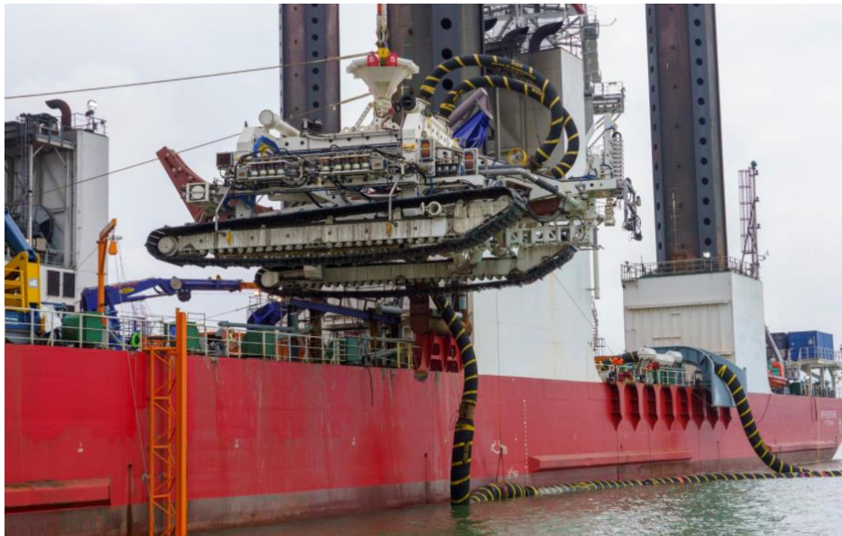
Figure 8 Van Oord Deep Dig-It (image courtesy of Van Oord)
